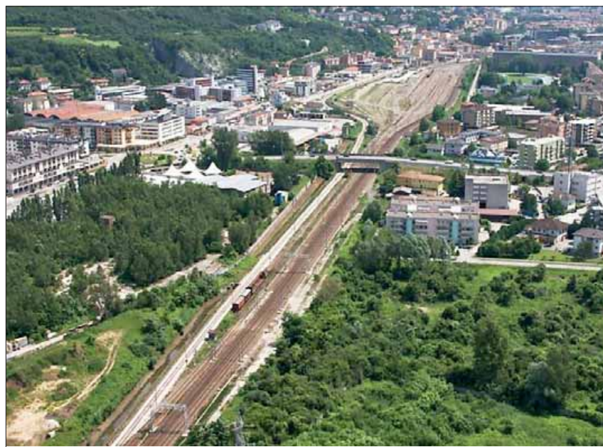
Una panoramica dell'area che sarà coinvolta dai lavori per la galleria del bypass ferroviario
